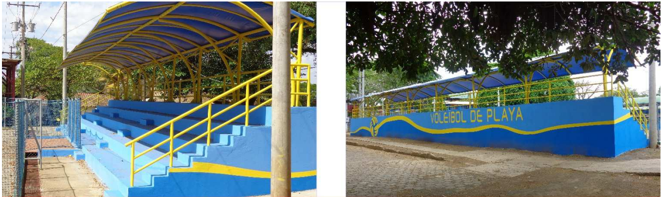
Vista panorámica de la ampliación de gradería costado Este, con proyecto ya finalizado y listo para su uso.
