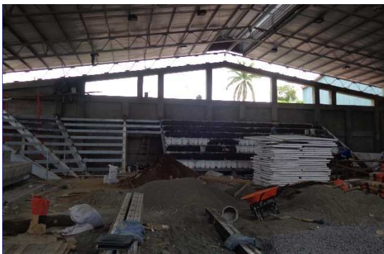
Observar vista interna de las instalaciones del Gimnasio de Boxeo, donde se aprecia la instalación de la estructura metálica principal y covintec de graderías. A la izquierda apreciar graderías costado Noreste y Este, a la derecha gradería costado Sur.
