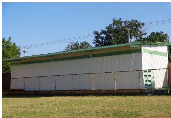
Vista panorámica de la infraestructura construida para la Academia de Boxeo con proyecto ya finalizado.
