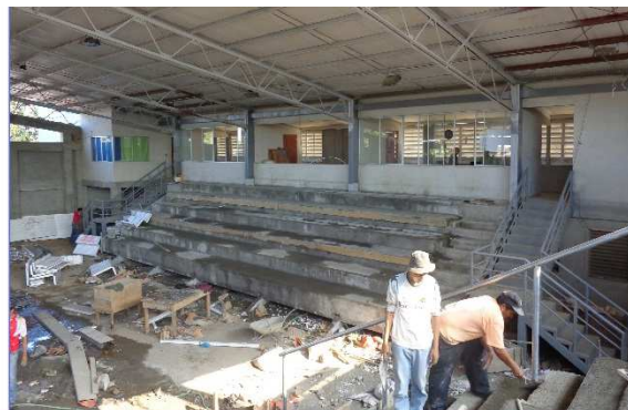
Observar vista interna de las instalaciones del Gimnasio de Boxeo, donde se aprecia la instalación de la estructura metálica principal y covintec de graderías. A la izquierda apreciar graderías costado Noreste y Este, a la derecha gradería costado Sur.
